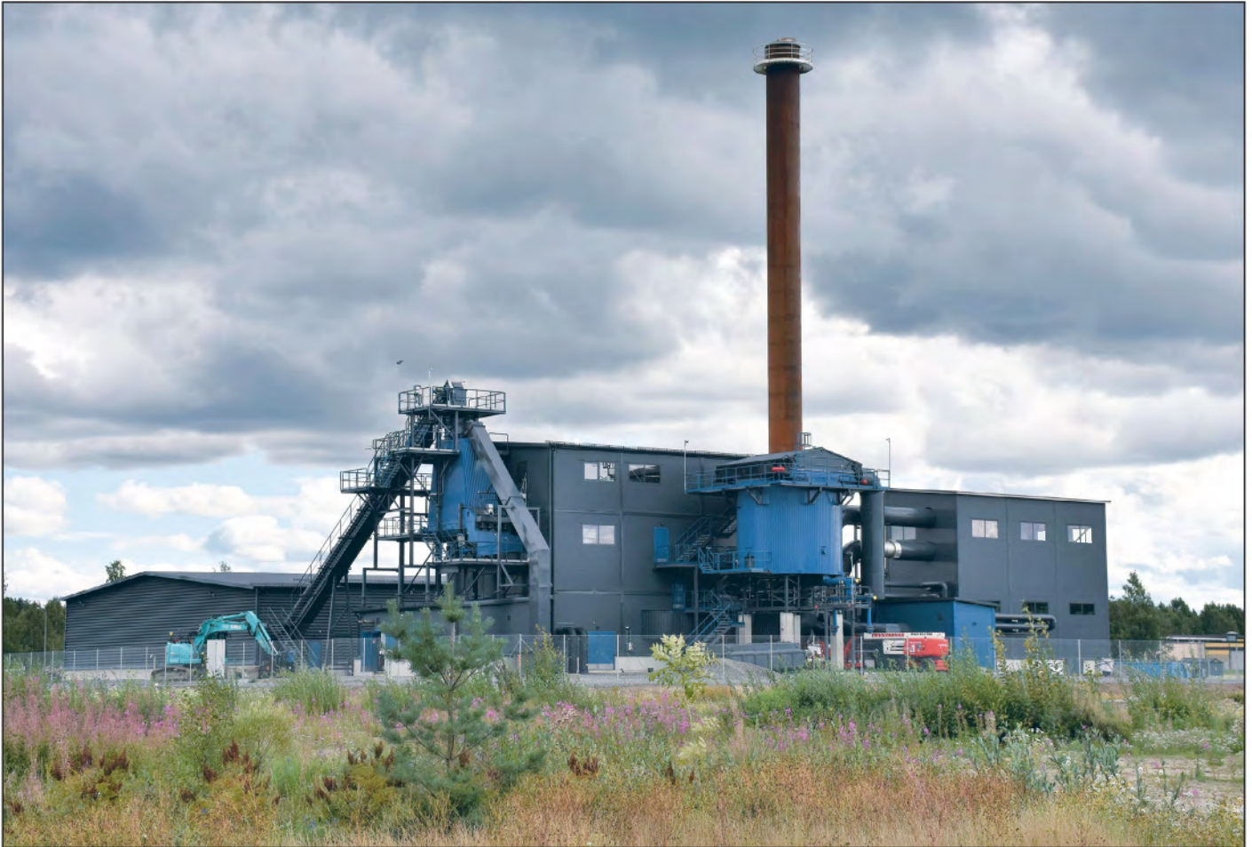
Tänä vuonna käyttöön otettu 14 MW lämpölaitos.
