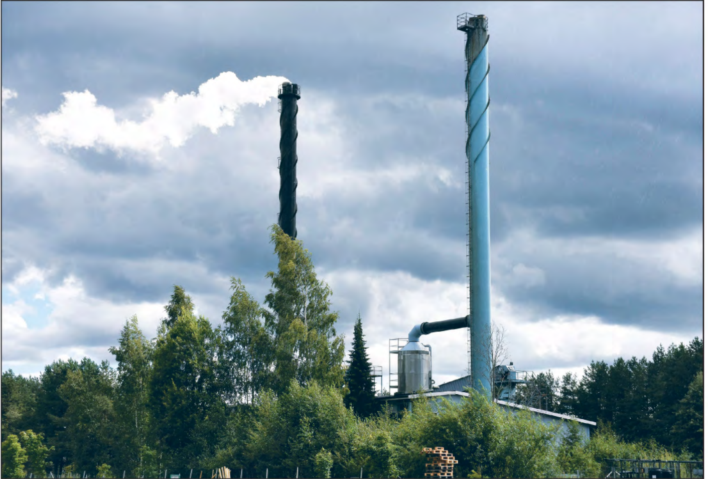
Lellavan lämpöyksiköt maastoutuvat jo hyvin ympäristöön.
